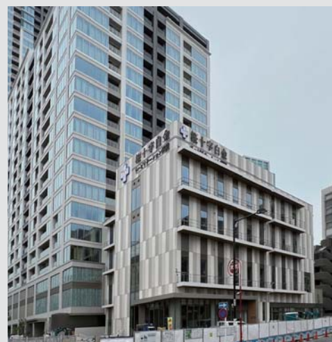
建設中 2022年6月撮影 Under construction, taken in June 2022
